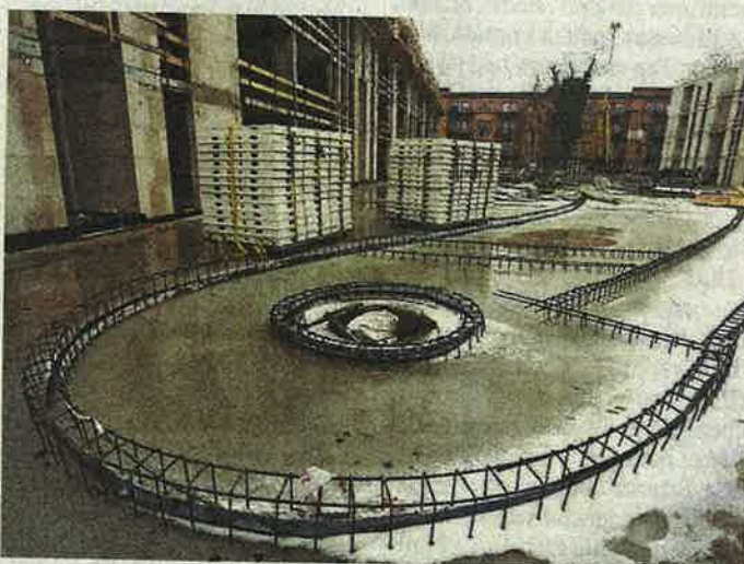
So sieht der Innenhof des Wohnquartiers mit dem geplanten 37 mal 50 Meter großen Wasserspiegel und der Insel „Long Island“ aktuell aus. Foto: Sergej Lepke
