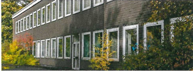
Die ehemalige Pädagogische Hochschule wird abgerissen.
