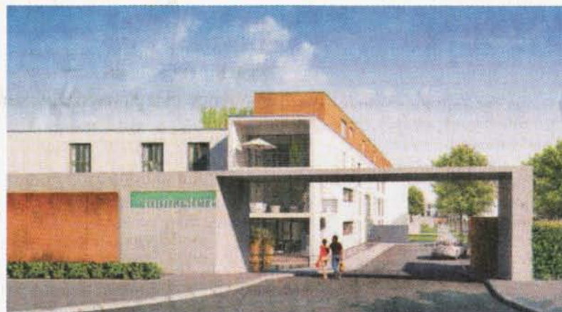
Die rostbraunen Stahlplatten an der langen Mauer neben dem Eingang zur Siedlung speichern Sonnenenergie.
